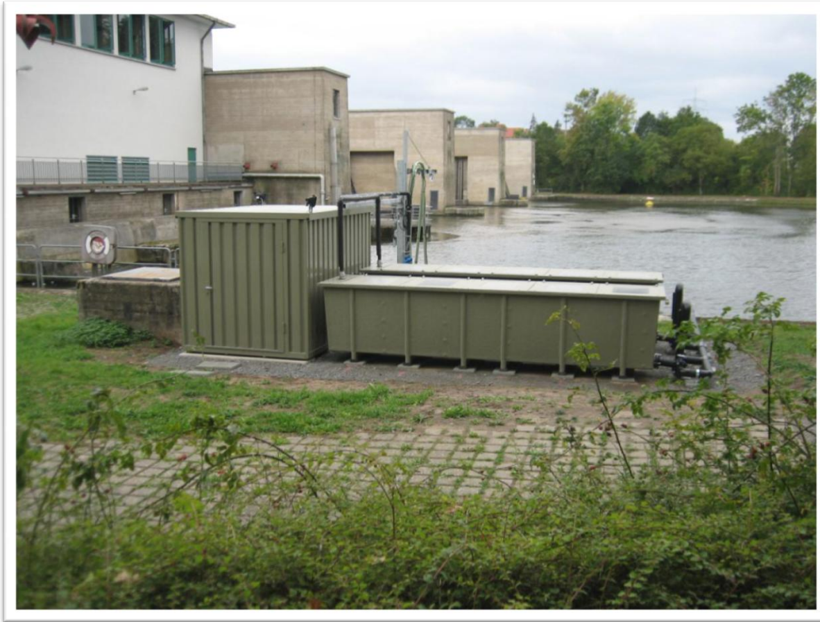
Betriebscontainer MIGROMAT mit den beiden Langstrombecken, Garstadt
