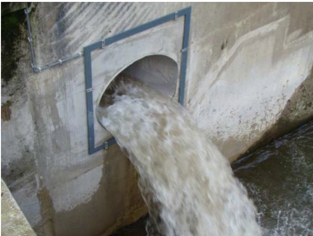
Abbildung 46: Ansicht einer PIT-Tag-Antenne im Bereich der Bypassöffnung einer Wasserkraftanlage in Belgien (Foto: M. Ovido)
