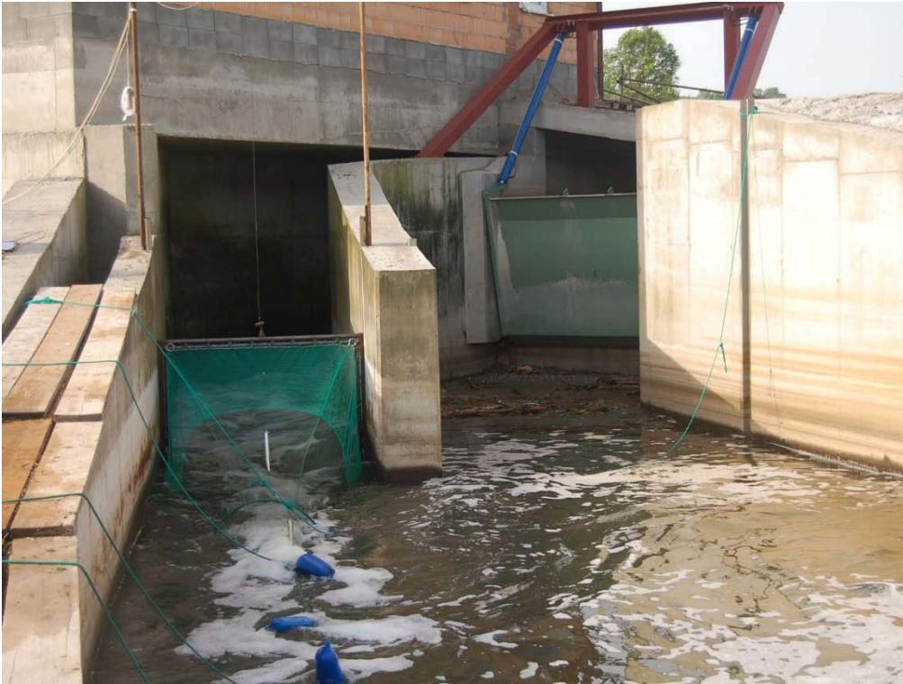
Abbildung 59: Schwalgreuse im Austrittsprofil eines schachtartigen Bypasses (Foto: G. Ebel)
