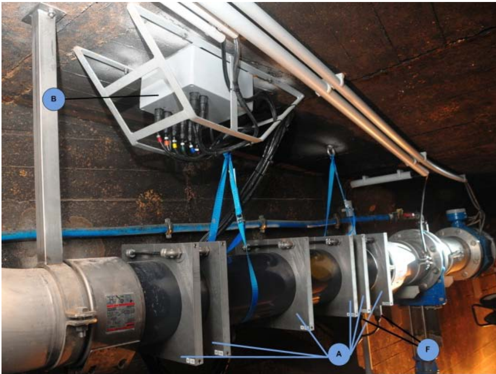
Abbildung 37 Ansicht eines Aal-Infrarot-Scanners, installiert an einem Abschnitt des Bypassrohres; A: Infrarotsender, B: Schaltschrank, F: Kameraeinheit (Foto: Profish Technology)
