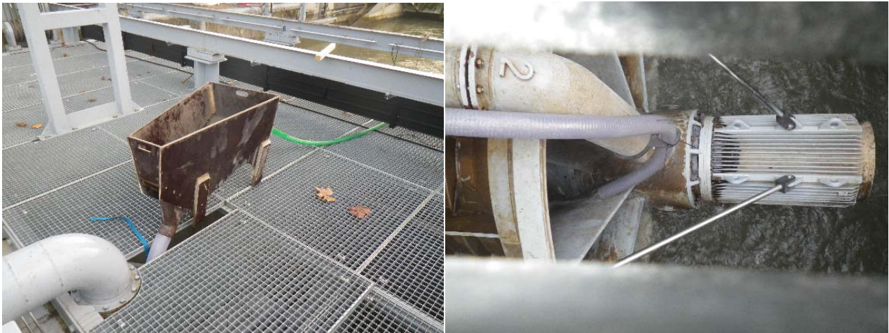
Abbildung 50: Apparaturen zur gezielten Fischinjektion; links: initialer Behälter für die Aufnahme von Blankaalen, rechts: am Leitapparat einer Kaplan-Turbine befestigtes Injektionsrohr (Fotos: Profish Technology)
