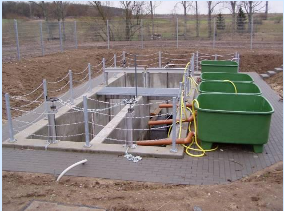
Fangkammer am Bypass an der WKA Dettelbach/Main
