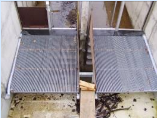
Fangkammer am Bypass an der WKA Dettelbach/Main
