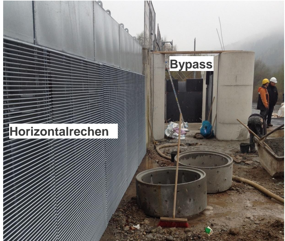
Horizontaler Feinrechen mit Bypass am KW Fahrnau (im Bauzustand)
