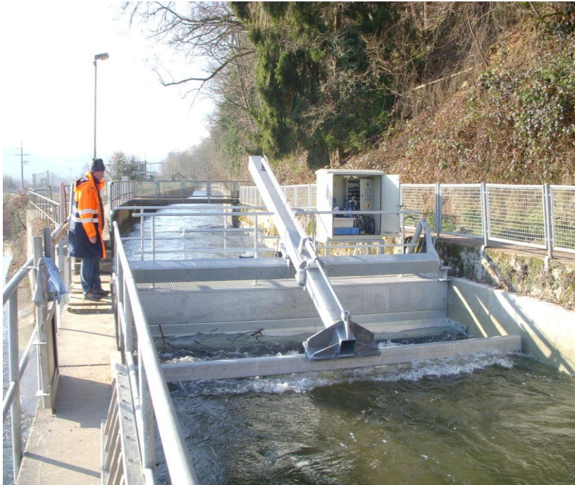
Vertikaler Feinrechen mit Bypass am KW Steinen
