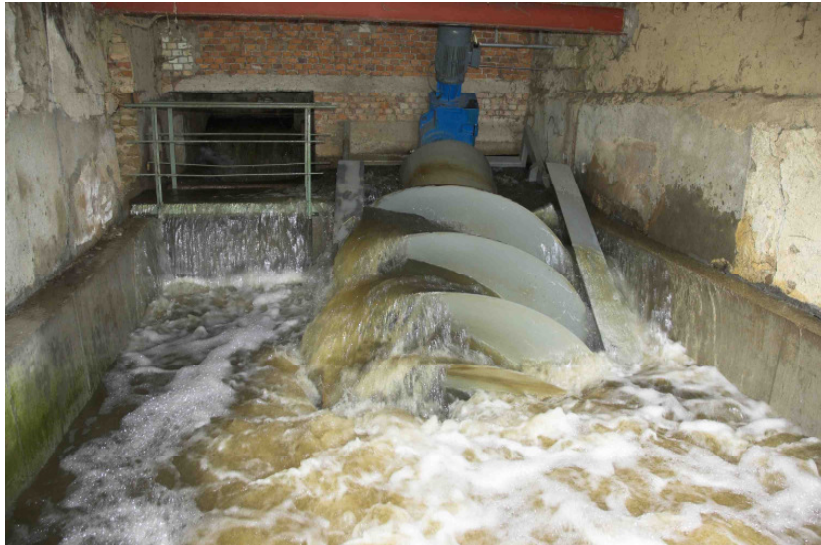
Abb. 41: Wasserkraftschnecke Gugelmühle / Wörnitz bei angestiegenem Unterwasserspiegel (Foto BT). In diesem Zustand war die Mortalitätsrate deutlich geringer als bei normalem Unterwasserstand (vgl. Abb. 39). Zudem erzeugte die Wasserkraftschnecke dabei kein „klatschendes Geräusch“.
