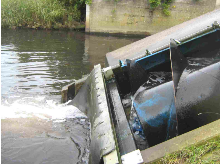
Abb. 39: Ausleitung Wasserkraftschnecke, die Schallschutzmatte ist eine mögliche Schädigungsquelle. Anscheinend wirken sich auch die hydraulischen Verhältnisse am unteren Ende der Schnecke (Foto CE) schädigend auf Fische einzelner Längenklassen aus.
