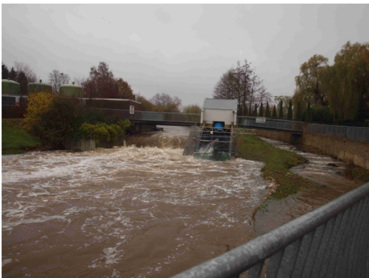
Abb. 40: Hochwassersituation in Krechting, der Fischabstieg ist nicht mehr erfassbar (Foto MG).
