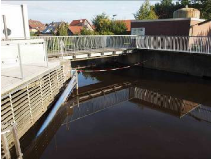
Abb. 5: Im Einlaufbereich der Schnecke war ein Grobrechen mit Schwemmbalken installiert (Foto MG).
