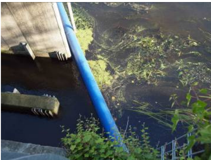
Abb. 6: Der Einlaufbereich der FAA war im Sommer dicht mit Wasserpflanzen bewachsen (Foto MG). Vor jeder Untersuchungswoche wurden die Wasserpflanzen aus dem Bereich stromab vom Schwemmbalken entfernt (im Bild: Bereich links vom blauen Balken).
