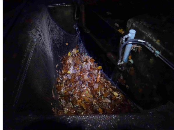
Rechengut im Auffangnetz
