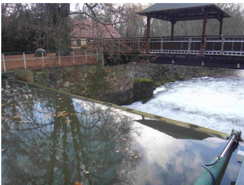
Abbildung 12: Wehrüberfall nach Zwangsabschaltung der Turbine durch den Netzbetreiber.
