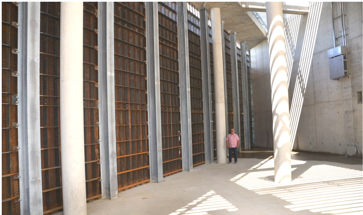
Leitrechen mit einer lichten Stabweite von 10 mm an einer Wasserkraftanlage mit einem Ausbaudurchfluss von 48 m 3 /s. Das Foto zeigt den Rechen von der Abströmseite vor der Inbetriebnahme (Foto: Ebel)
