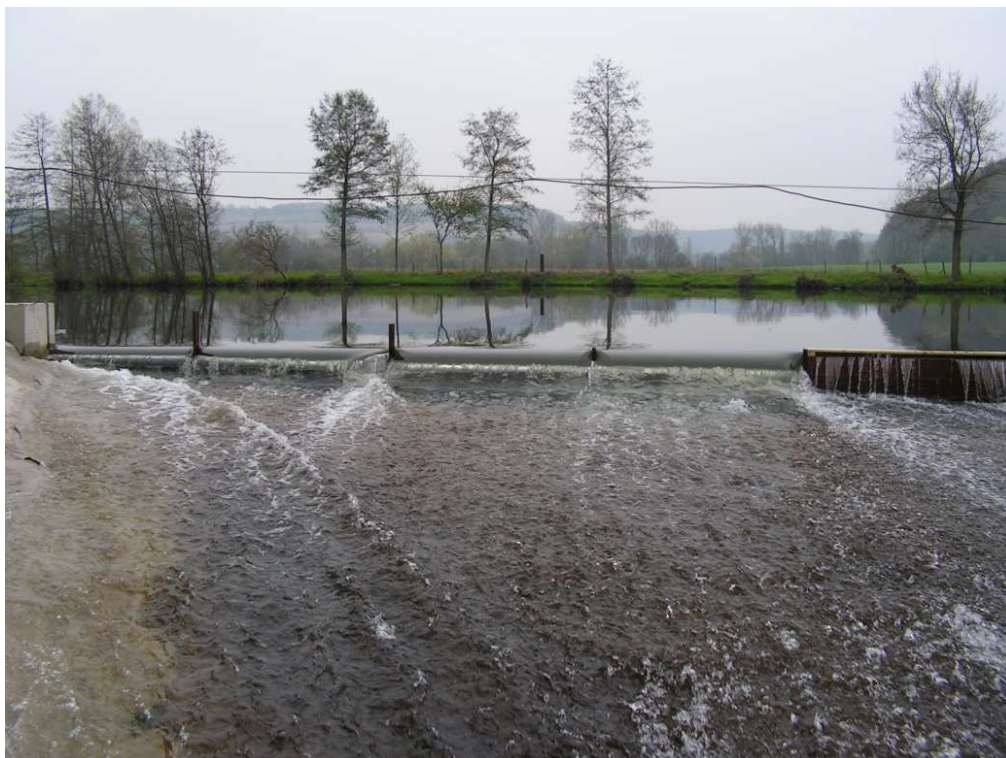
Foto 16: Öffnung der Wehrfelder zur Restwasserabgabe 2005: nur das obere Brett wurde entfernt
