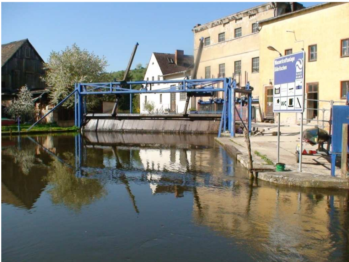
Foto 2: Rechenanlage der WKA Döbritschen
