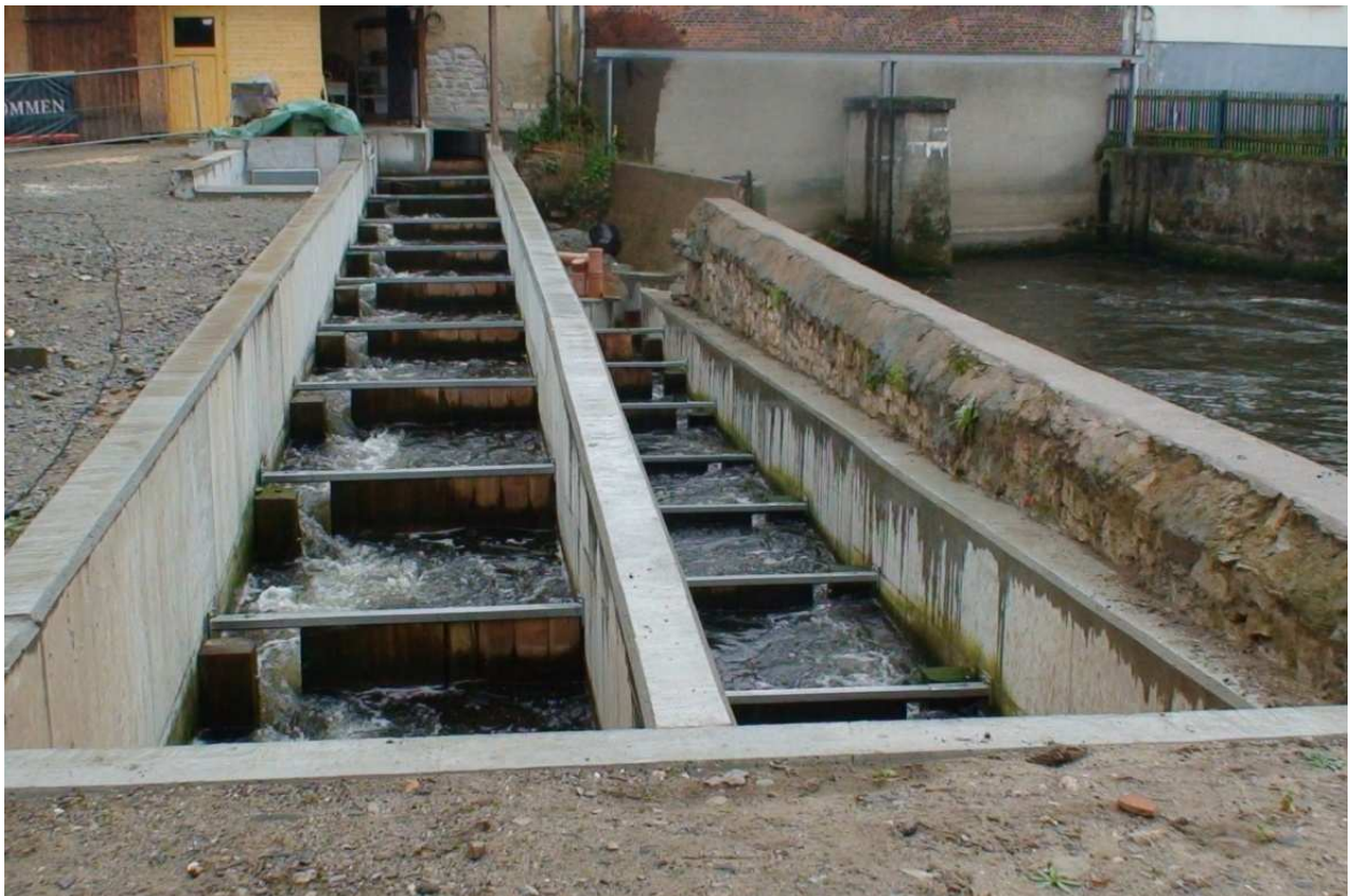
Foto 28: Schlitzpass in Betrieb
