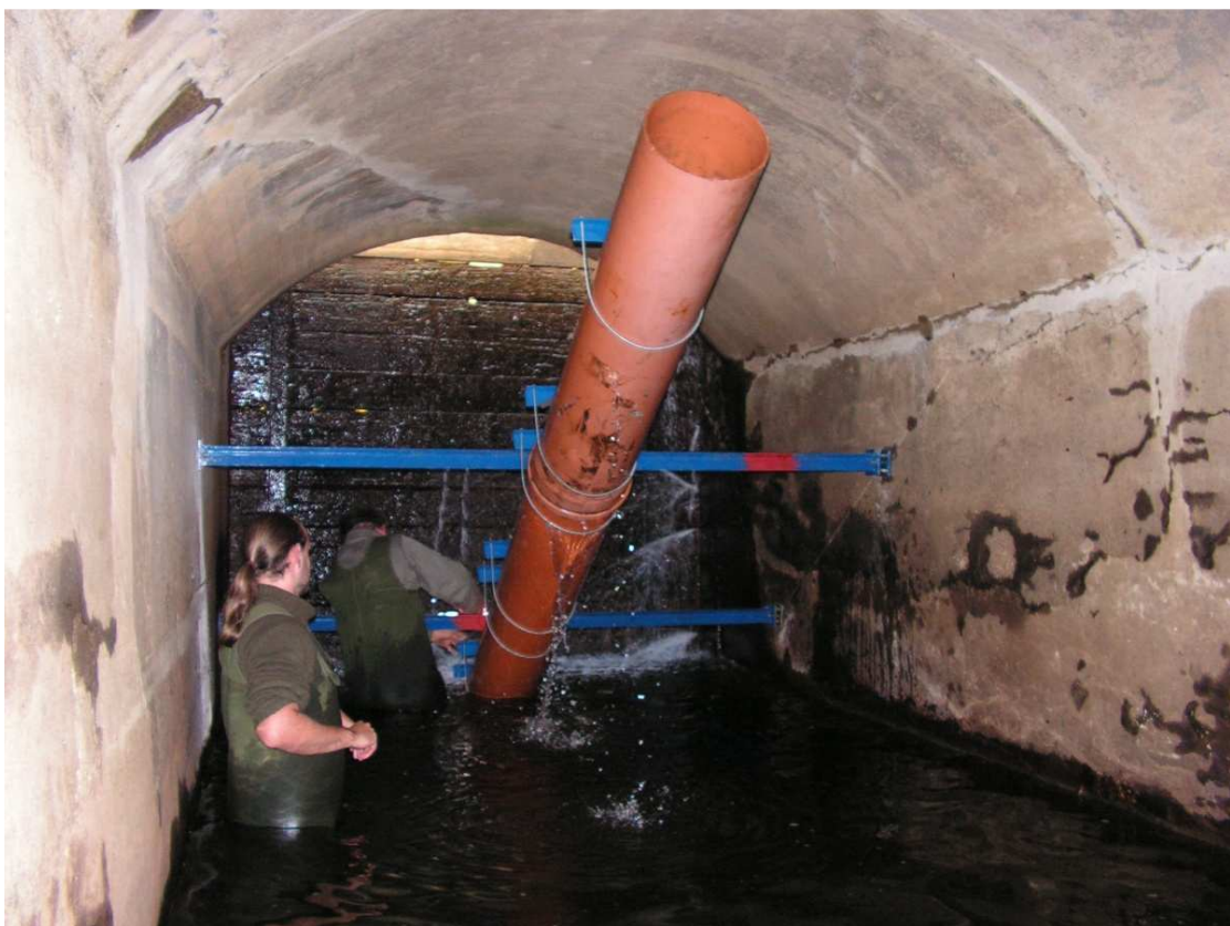
Foto 18: Bypassrohr im Leerschusskanal
