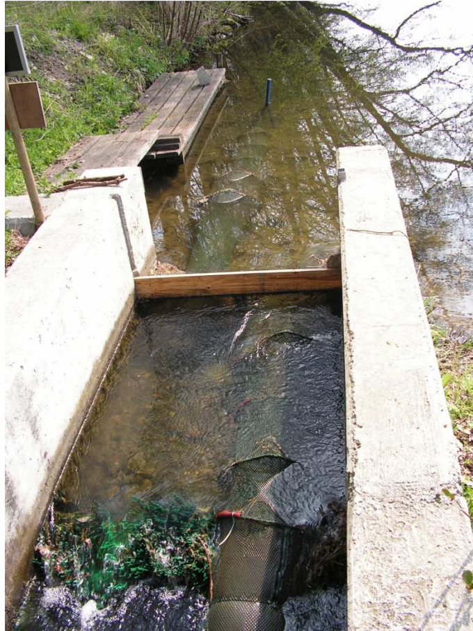
Foto 15: Doppelreuse im Einstieg des Borstenfischpasses
