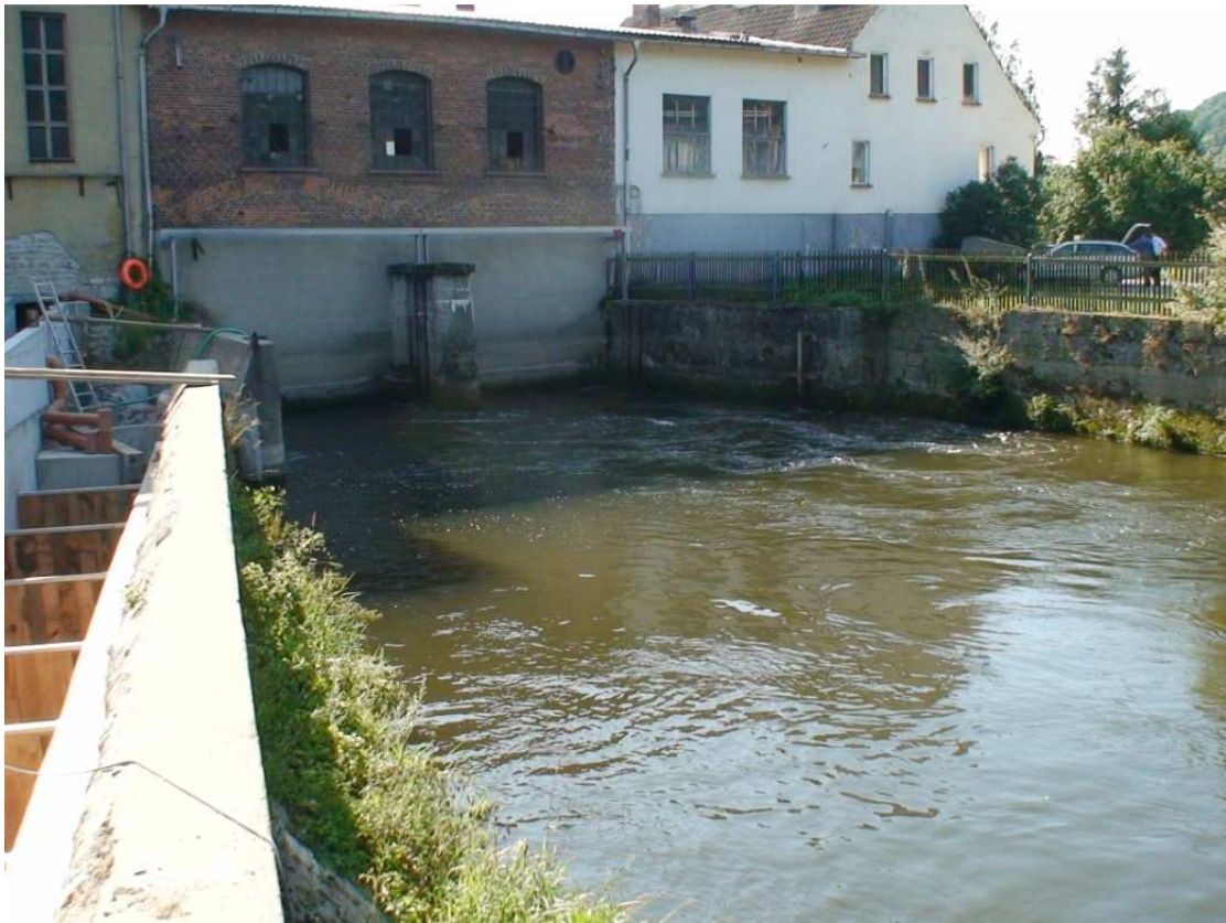
Foto 9: Turbinenkanal, Turbulenzzone unterhalb des Wasseraustritts
