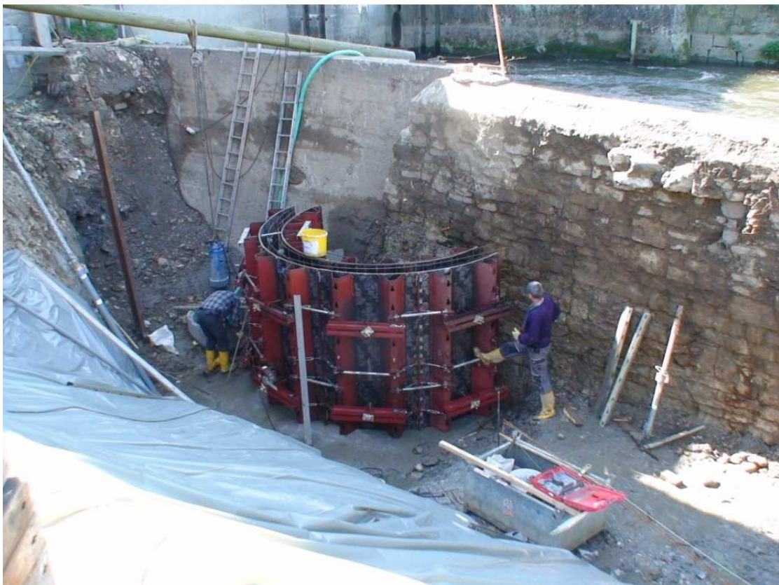
Foto 20: Bau des Vorbeckens für den Schlitzpass
