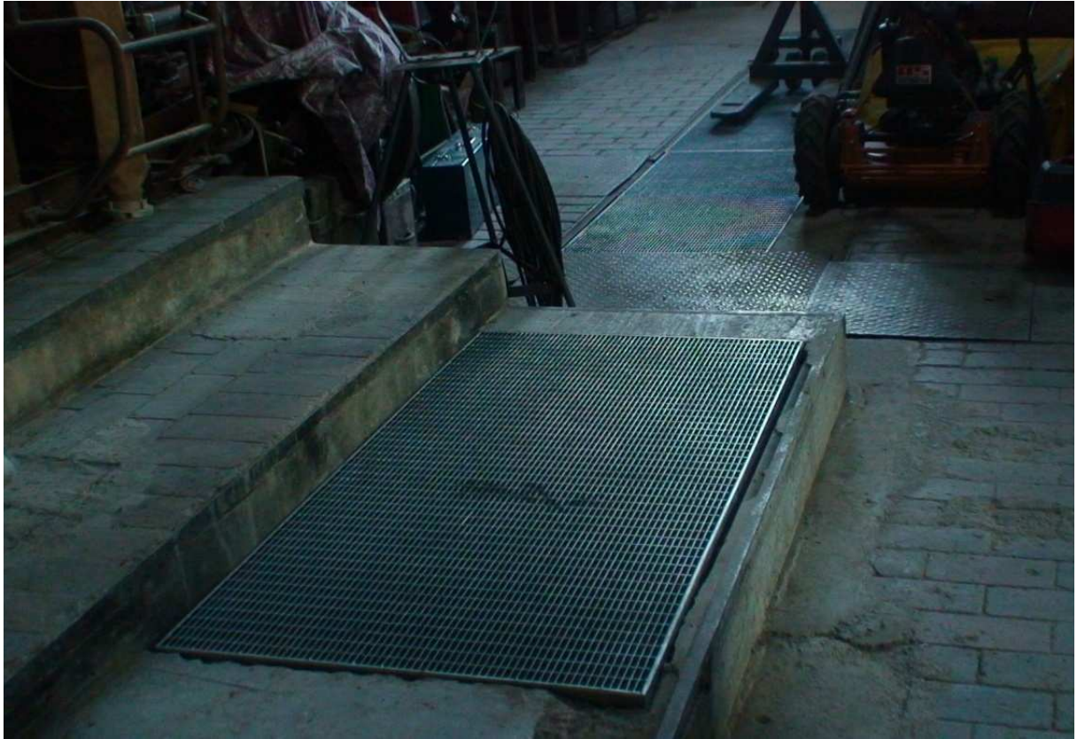
Foto 27: Gitterroste im Betriebsgebäude zur Abschwächung der Verdunkelungswirkung
