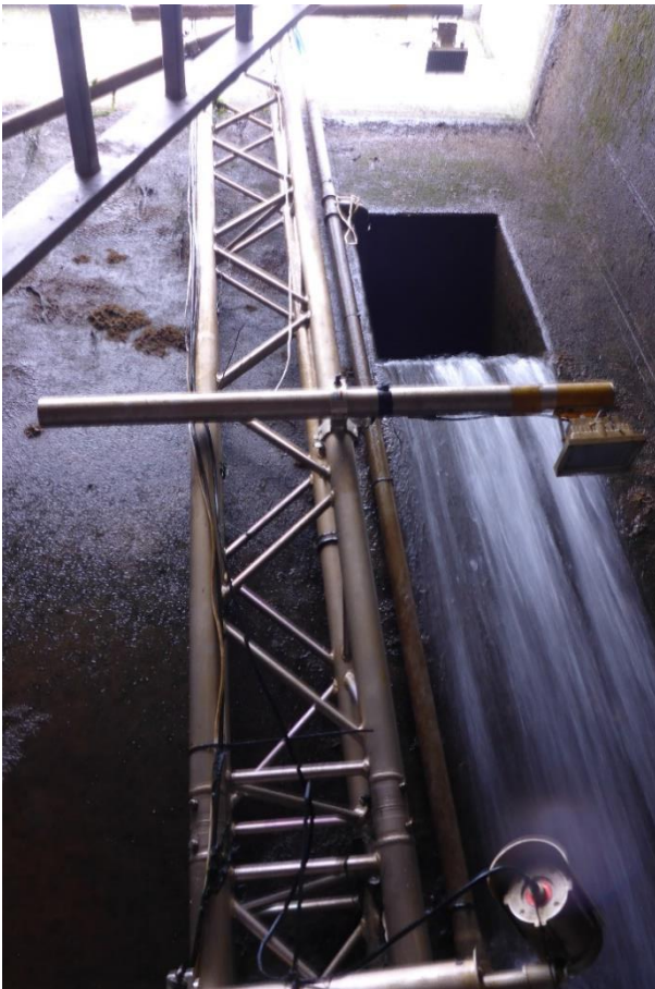
Abbildung 22: Oberer Teil der Traverse im Bypass mit daran montierten Unterwasserkameras und Scheinwerfern zur Erfassung der Ein- und Ausschwimmereignisse an den Bypassöffnungen
