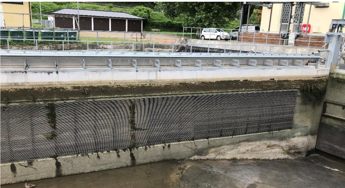
Abbildung 11: Teil des Fischschutzsystems an der Wasserkraftanlage Rappenberghalde am Neckar bei Tübingen. Blick auf den horizontalen Leitreechen mit 15 mm lichtem Stababstand und Betonsockel. Am rechten Bildrand ist das Schütz zum Leerschuss teilweise zu sehen
