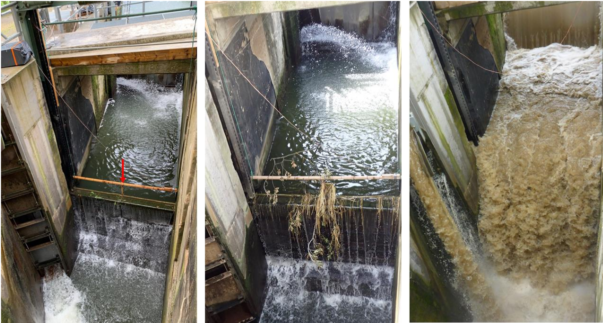
Abbildung 31: Antenne (roter Pfeil) im Leerschuss vor Zusammenfluss mit Bypass. Das linke Bild zeigt den Leerschuss in geschlossenem Zustand und den Bypass gegen Ende der Entleerungsphase mit angehobenem Registerschütz (links). In der Mitte ist die Antenne durch Rechengut versetzt. Das rechte Bild zeigt den Leerschuss im geöffneten Zustand (Notfallöffnung) und den Bypass in der Wartephase mit geschlossenem Schütz und überflossenem Überlauf
