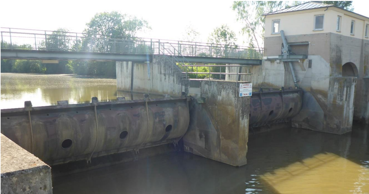
Abbildung 6: Ausleitungwehr aus dem Unterwasser fotografiert (Krafthaus mit Restwasserturbine und Fischaufstiegsanlage außerhalb des linken Bildrandes, Kanal zum Kraftwerk außerhalb des rechten Bildrandes)
