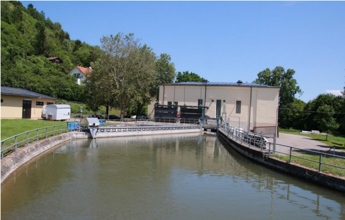
Abbildung 4: Krafthaus der WKA Rappenberghalde mit horizontalem Leitreechen aus dem Oberwasser fotografiert
