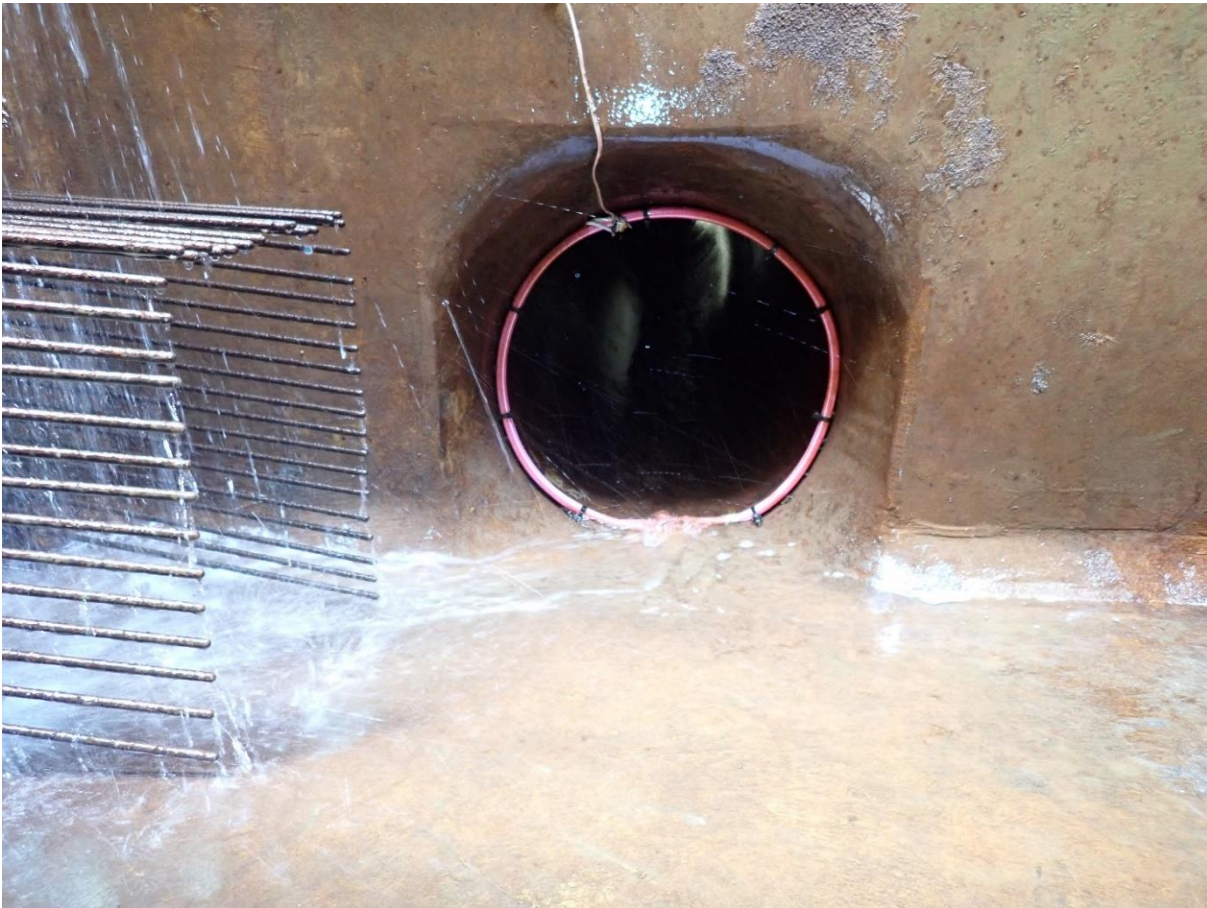
Abbildung 30: Antenne am Bypassausgang. Die Antennenkabel sind zur Stabilisierung in einem Ringförmigen Kunststoffrohr verlegt und über diesen am Beton verankert
