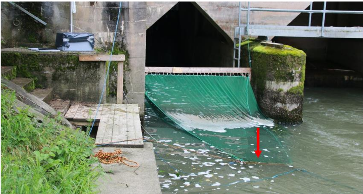
Abbildung 32: Antenne (roter Pfeil) im Unterwasser der alternativen Subkorridore Leerschuss und Bypass
