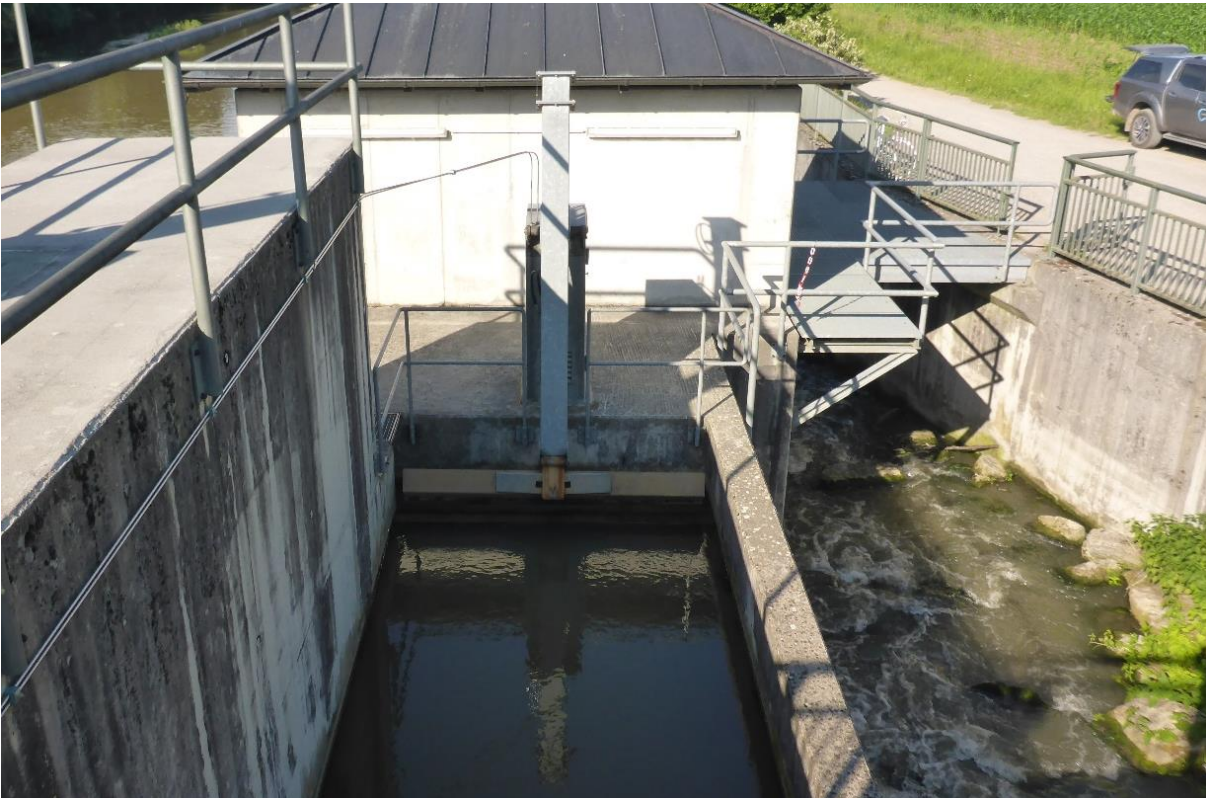
Abbildung 8: Krafthaus der Restwasserturbine mit Zufluss (mittig) und Fischaufstiegsanlage (rechts) am Ausleitungswehr
