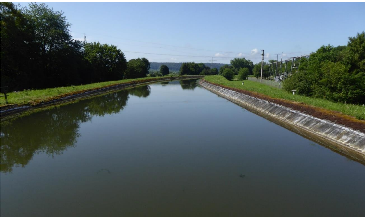
Abbildung 9: Kanal mit Trapezprofil oberhalb der Wasserkraftanlage Rappenberghalde
