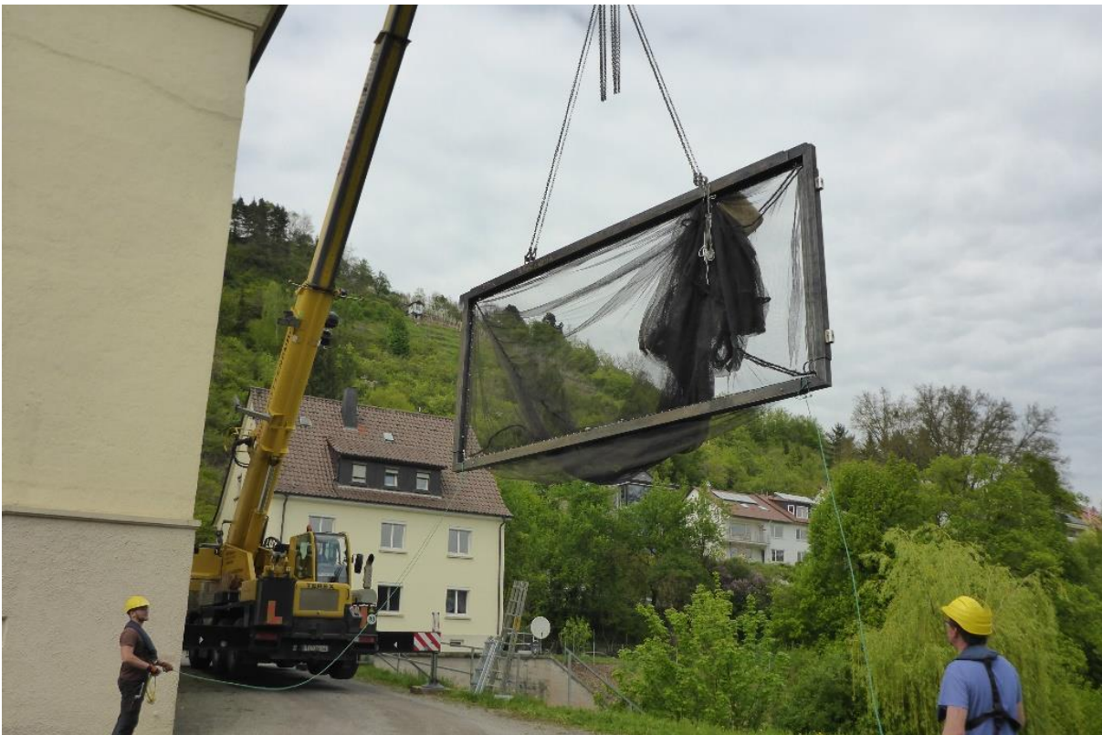
Abbildung 34: Installation des Hamens für die Hauptturbine während der ersten Untersuchungskampagne
