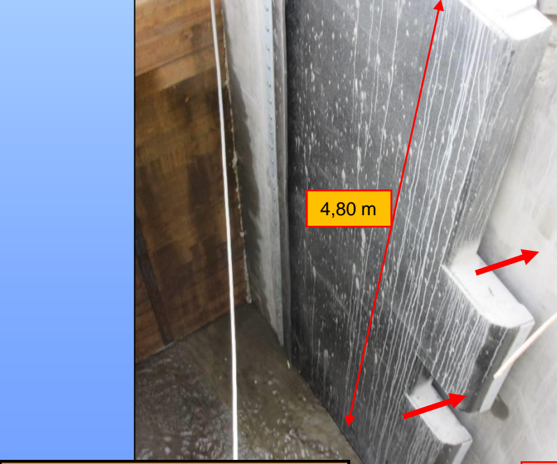
Leitrechen-Bypass-System EBEL, GLUCH & KEHL (2001)
