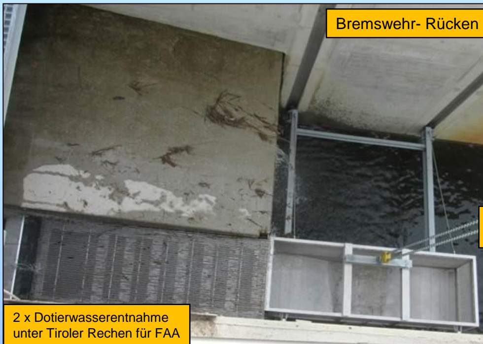
Fangkorb Floecksmühle zur Fisch-Abstiegskontrolle
