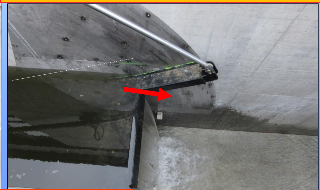
Fischfreundliche Schlitzdichtung und gratfrei abgerundete Kanten
