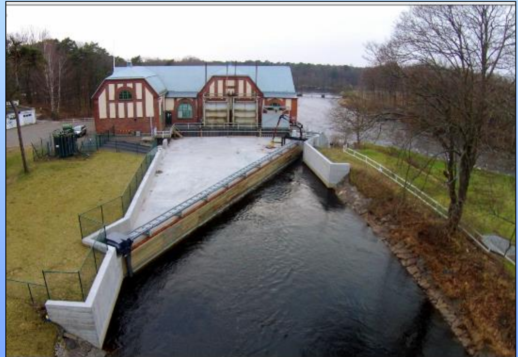
Abb. 9: Leitrechen-Bypass-System nach EBEL, GLUCH & KEHL an der WKA Falkenberg (Ätran) in Schweden (Foto: M. Hebrand).
