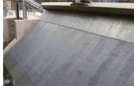
**Abbildung 1:** Skizze der Seitenansicht eines Flachrechens mit Spülrinne und Bypass (links) und Ausführungsbeispiel an einem Wasserkraftwerk (rechts).
