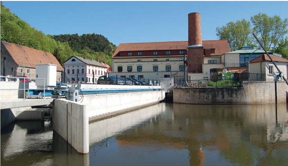
Abb. 13: An der Wasserkraftanlage Freyburg (Unstrut, Deutschland) wird der 10-mm-Leitrechen durch Edelstahlprofile vom Typ Oppermann gebildet.
