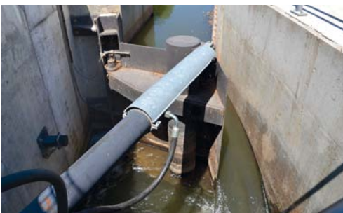
Abb. 14: Schachtartige Bypässe mit selbstreinigenden Regelorganen ermöglichen bei geringem Unterhaltungsaufwand einen dauerhaft funktions-sicheren Betrieb. Oben: Bypass im Bau (Blick zum Unterwasser), unten: Eintrittsbereich eines Bypasses mit selbstreinigender Klappe im Betrieb (Blick zum Oberwasser). Fotos: G. Ebel
