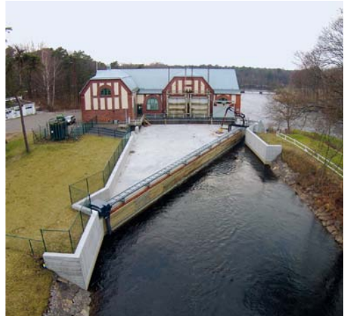
Abb. 9: Leitrechen-Bypass-System nach Ebel, Gluch & Kehl an der WKA Falkenberg (Ätran) in Schweden Foto: M. Hebrand
