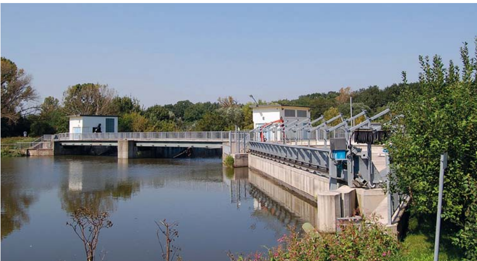
Abb. 1: Pilot-Wasserkraftanlage Halle-Planena mit Leitrechen-Bypass-System nach Ebel, Gluch & Kehl Foto: G. Ebel
