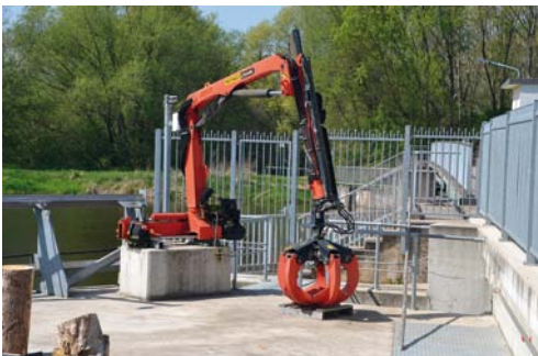
Abb. 6: Am Eintrittsprofil des Bypasses der WKA Halle-Planena installierter Hydraulik-Ladekran
