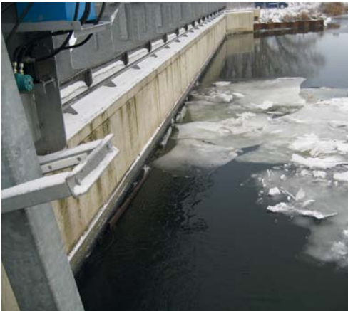
Abb. 8: Durch die schräge Anordnung des Rechenfeldes wird auch die Ableitung von Eisschollen in den Bypass unterstützt. Foto: A. Gluch
