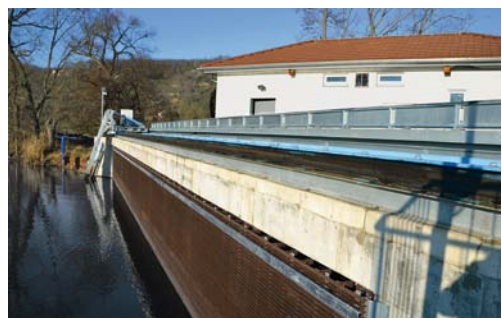
Abb. 5: Rechenreinigungsmaschinen der Pilot-Wasserkraftanlagen. Oben: WKA Halle-Planena (Arbeitsposition, Ansicht von oberstrom), unten: WKA Öblitz (Ruheposition, Ansicht von unterstrom). Fotos: G. Ebel
