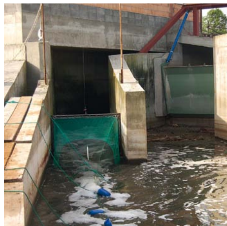
Abb. 16: Untersuchungen zur biologischen Wirksamkeit von Fischschutz- und Fischabstiegssystemen erfolgen oftmals mit netzartigen Fanggeräten, die in den Austrittsprofilen der Saugrohre (links) sowie im Austrittsprofil des Bypasses (rechts) installiert werden. Fotos: G. Ebel
