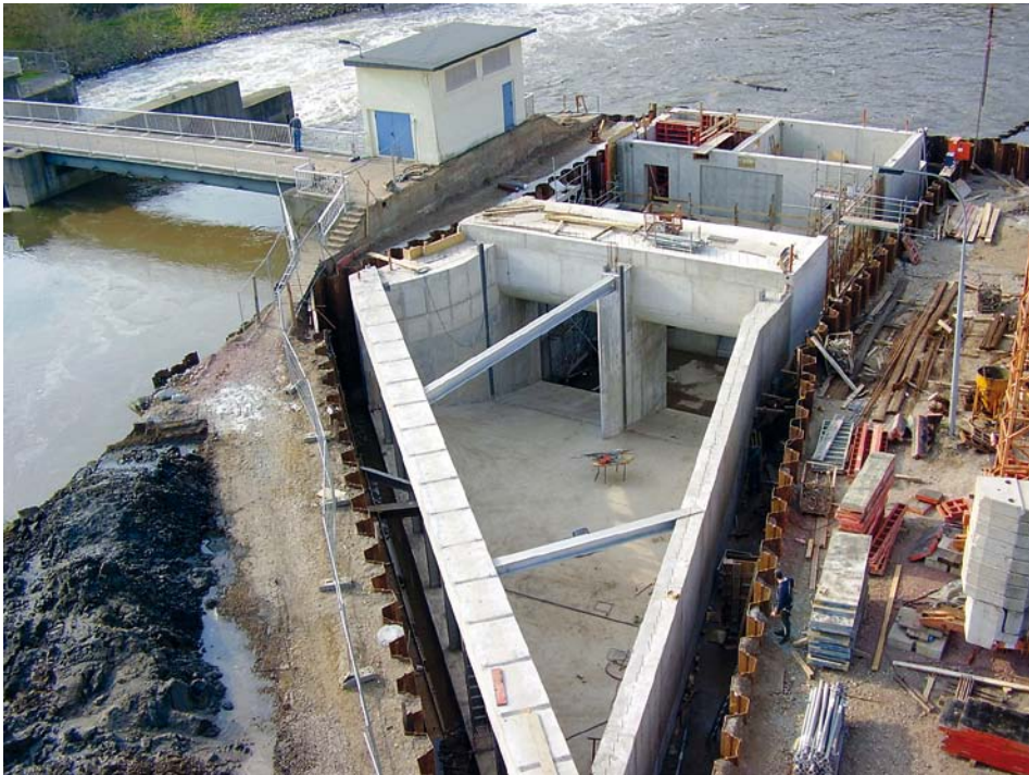
Abb. 3: Die als Buchtenkraftwerk konzipierte WKA Halle-Planena wurde rechtsseitig der Staustufe im Gewässervorland errichtet. Foto: M. Kehl
