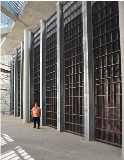
Abb. 10: Bei dem Leitreechen der WKA Öblitz handelt es sich nach vorliegenden Kenntnissen um den derzeit größten 10-mm-Rechen Europas. Das Foto zeigt den Rechen von der Abströmseite vor der Inbetriebnahme. Foto: G. Ebel
