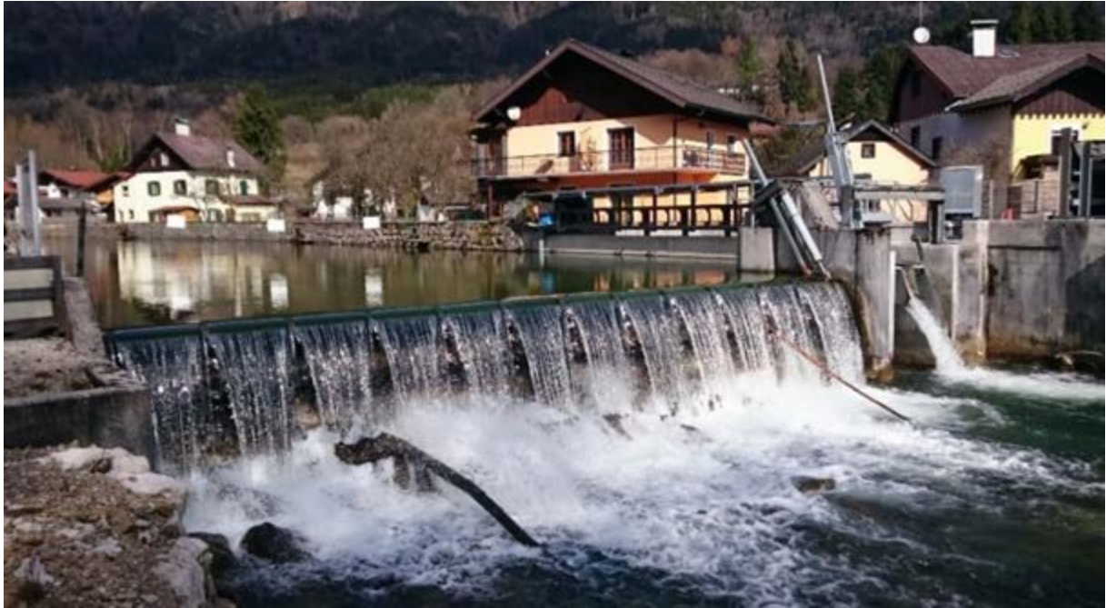
Abbildung 6: Wehrfeld bei geringem Wehrüberlauf sowie Fischabstiegsklappe (links) des KW Ebewe. Im Unterwasser des Wehrfeldes sind die Steinschichtungen zur Absicherung der Wehranlage zu erkennen. (Foto: K. Pinter)
