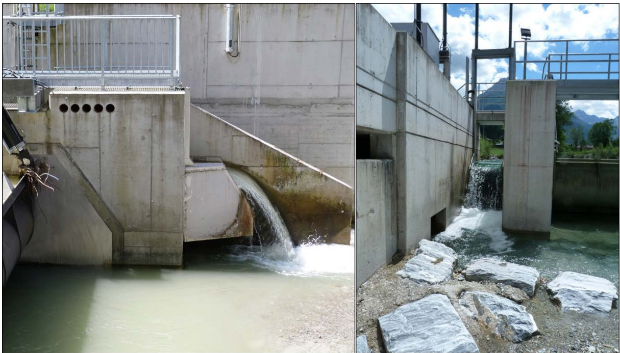
Abbildung 2: Fischabstiegshilfen an den Wehranlagen der Kraftwerke Fritzbach (links) und Kleinarler Ache (rechts). In beiden Fällen fungieren die Klappen auch als Restwasserdotationsbauwerke.
