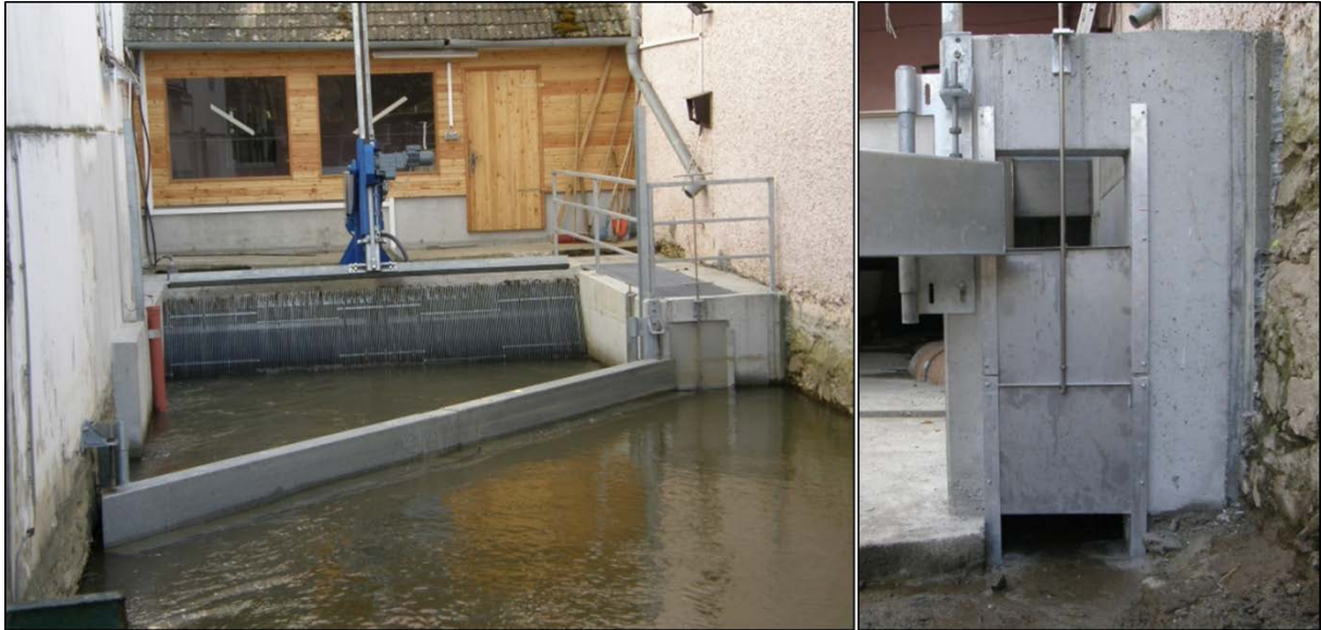
Abbildung 4: Fischabstiegsanlage am Kraftwerk Riedmühle an der Thaya. Die Öffnungen zur Bypassleitung sind flussauf versetzt vom Feinrechen angebracht. Oberflächlich dient eine Tauchwand, am Boden ein Betonsockel als Leiteinrichtung. (Fotos: R. Bentz)
