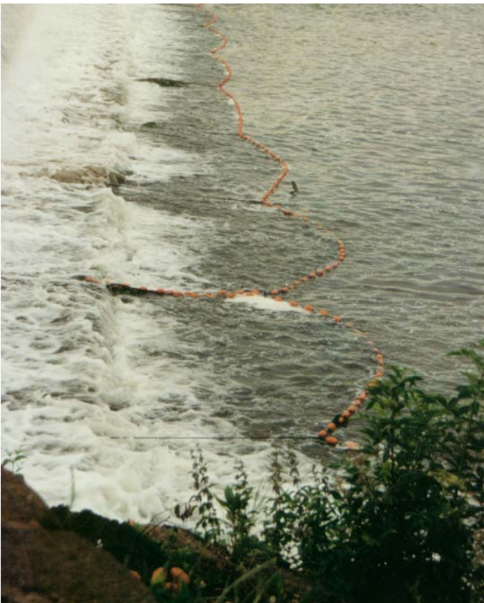
Foto 34: bei höherer Wasserführung über das Wehr sind die 2,2 m langen Seile zwischen Schwimmerleine und Befestigungskette am Wehrfuß zu erkennen
