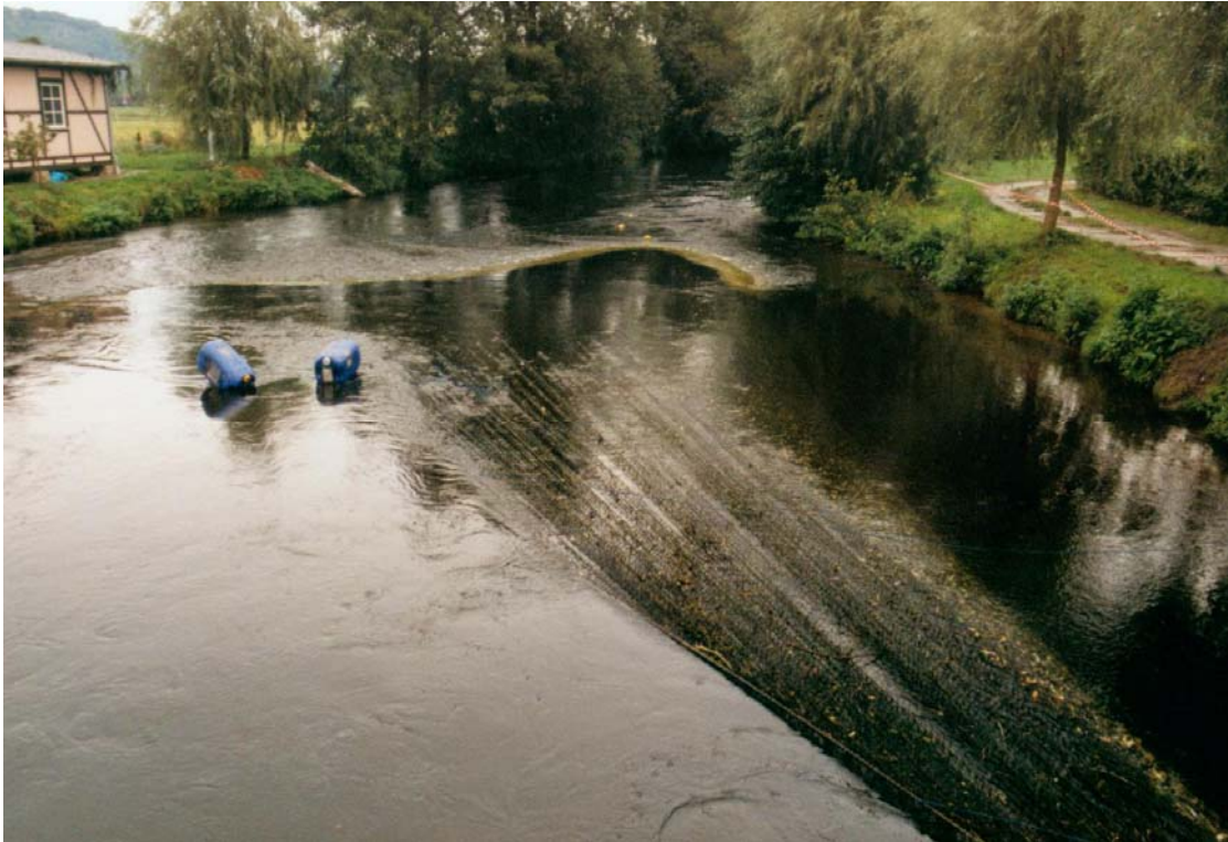
Foto 23: Nach Lockerung der Stahlseile blieb der Hamen aufgrund des stabilisierenden Wasserdruckes aufgebläht im Mühlgraben stehen.
