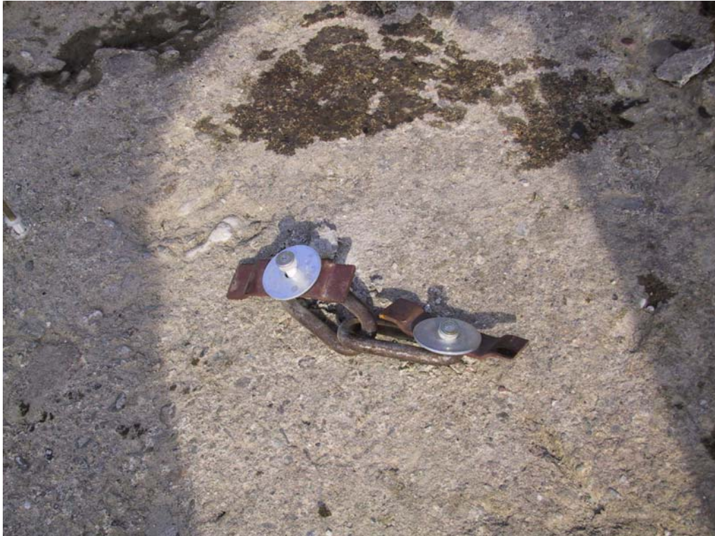
Foto 35: durch Kettenglieder in den Beton geschossene Stahlstifte
