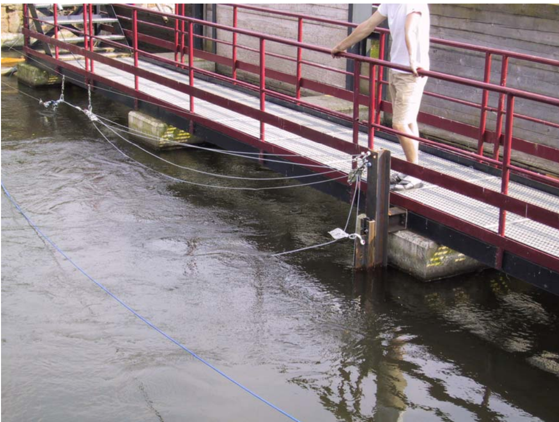
Foto 6: linker Stahlträger mit montierten Umlenkrollen
