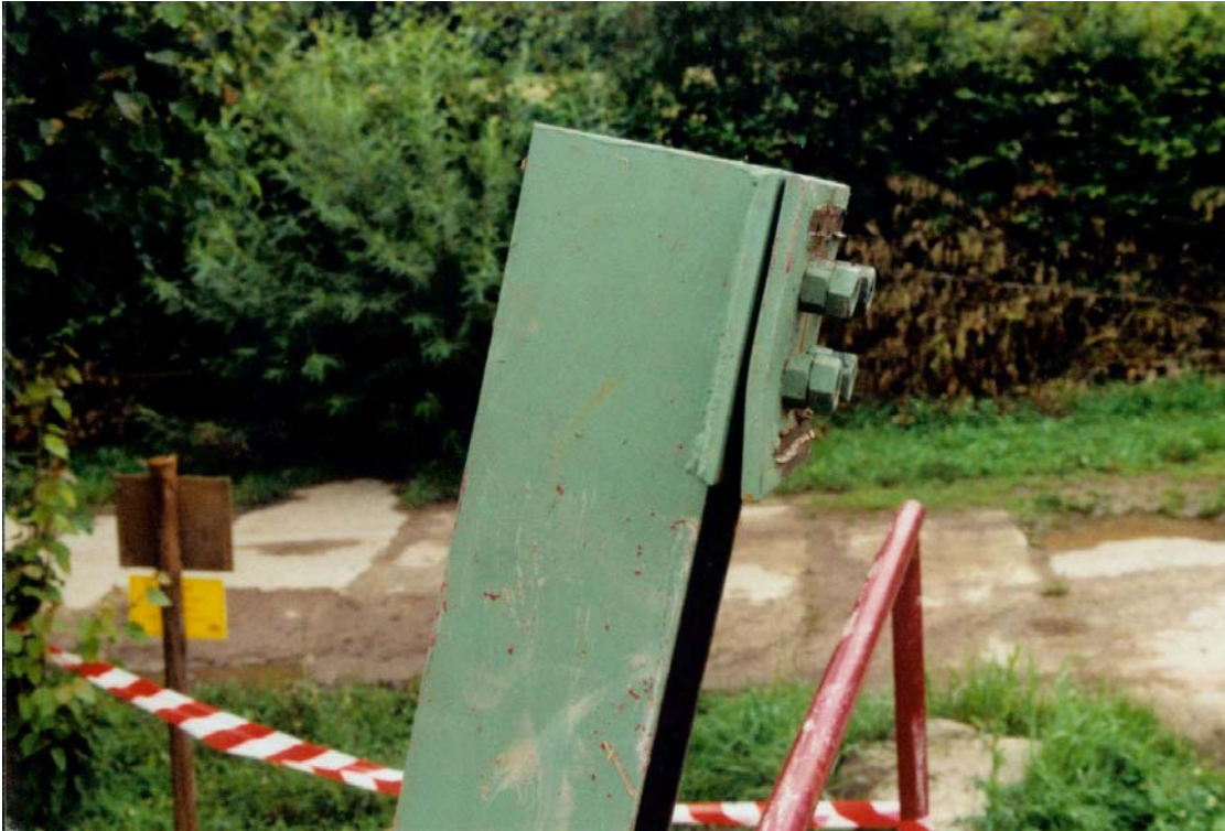
Foto 13: Detailaufnahme der gebrochenen Schweißnaht
