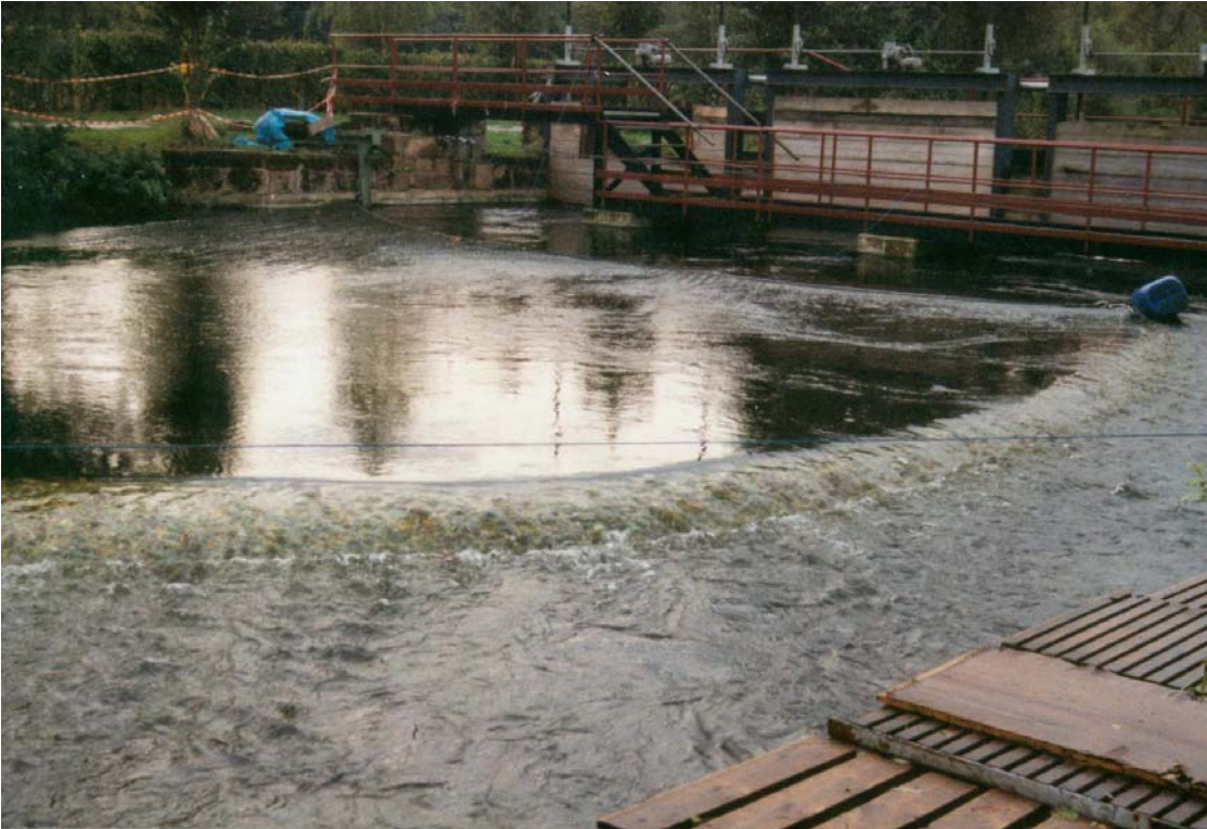
Foto 21: aufgestautes Wasser im vorderen Hamenbereich
