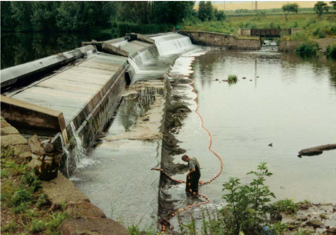
Foto 33: am Wehrfuß angebrachtes Netz
