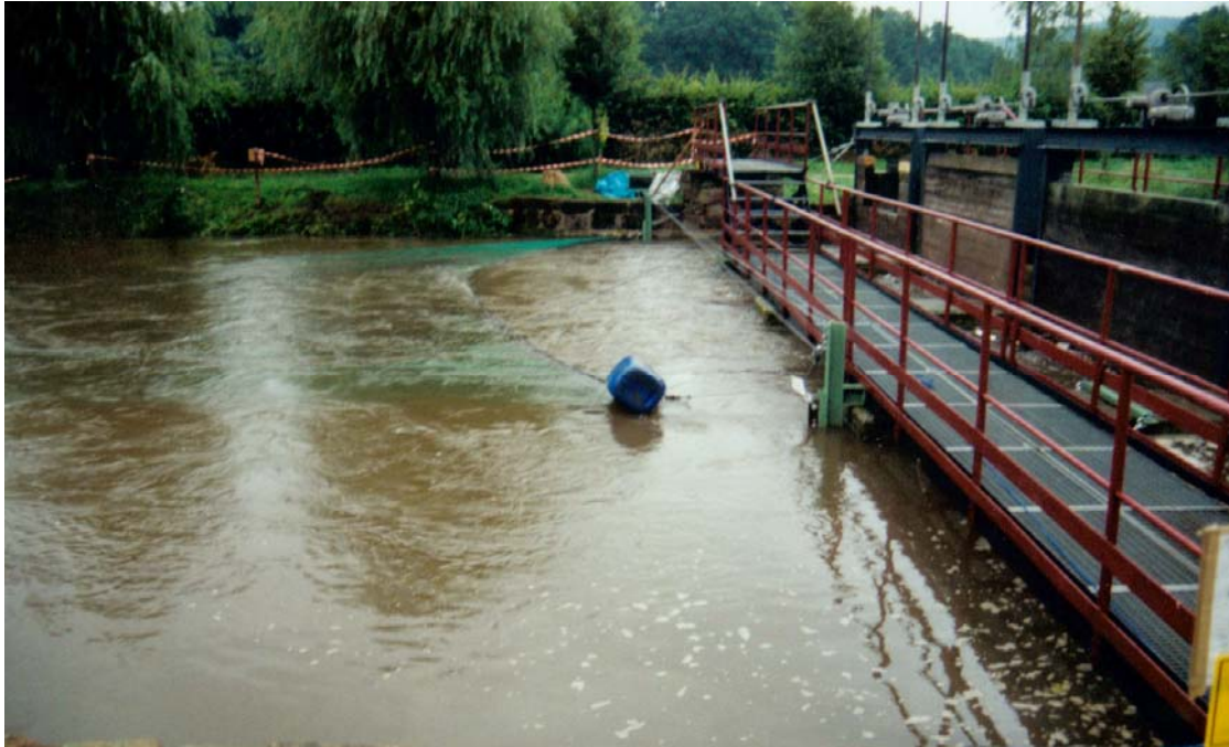
Foto 11: Abfluß von etwa 15 \text{ m}^3/\text{s} durch den Hamen in Richtung Wasserkraftanlage
