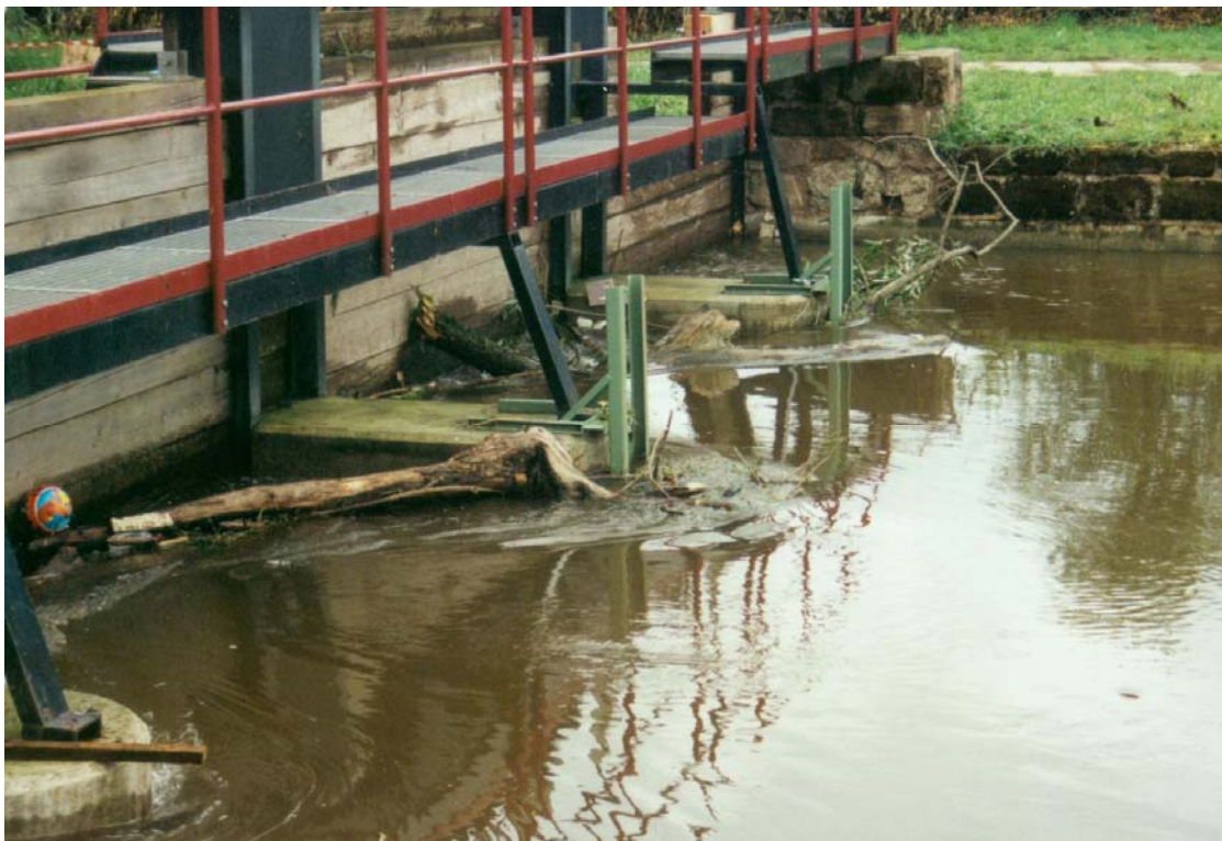
Foto 32: knapp ins Wasser eintauchende Schütztafeln mit hängengebliebenem Schwemmaterial
