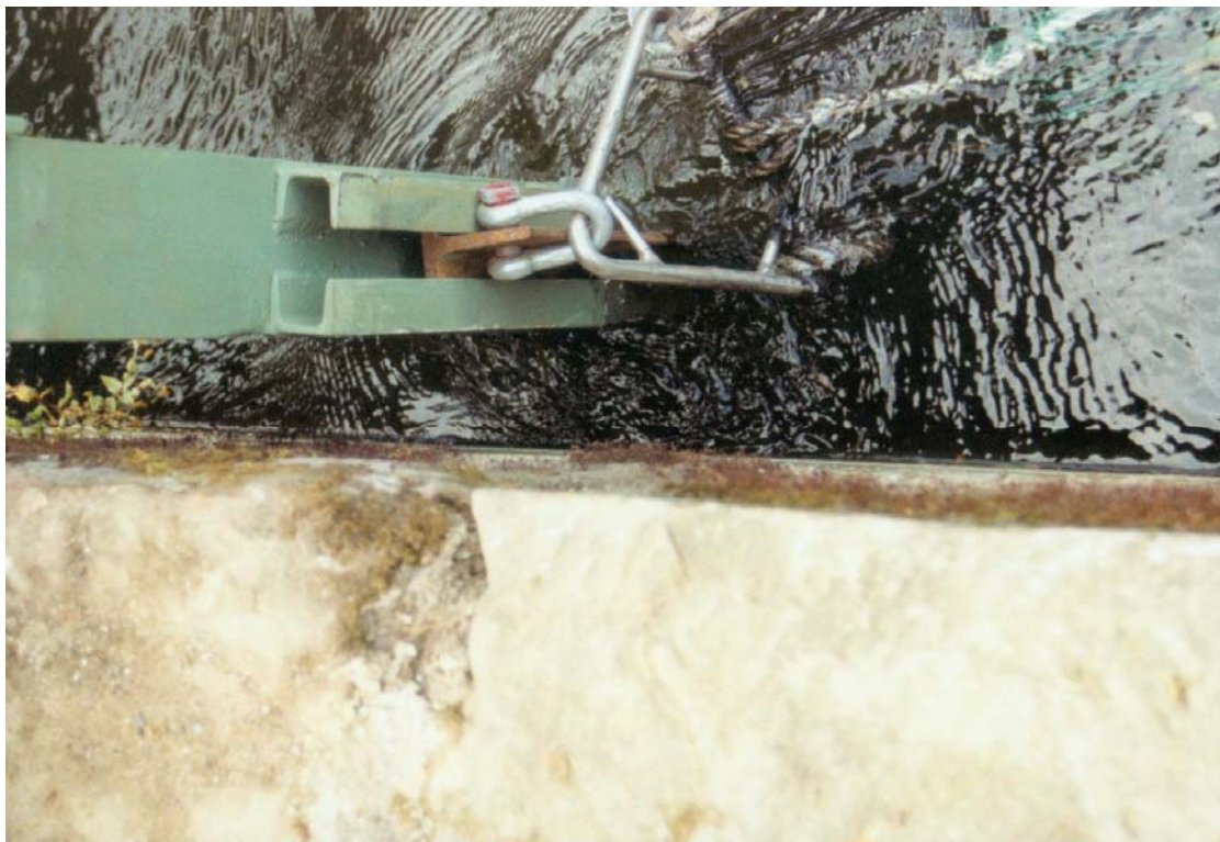
Foto 4: Detailaufnahme des in den rechten Stahlträger eingeführten T-Profiles
