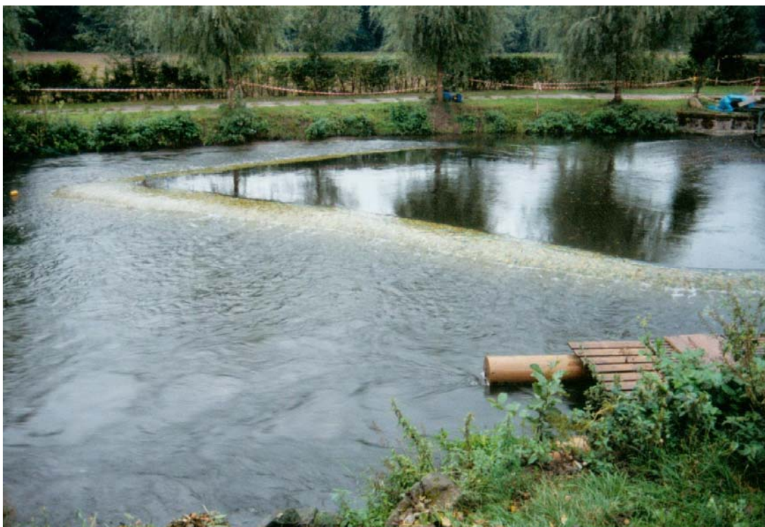
Foto 22: aufgestautes Wasser im hinteren Hamenbereich
