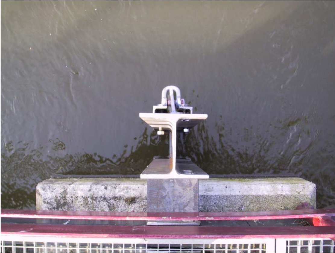
Foto 5: Draufsicht auf den linken Stahlträger mit eingeführtem T-Profil incl. Fischereischäkel
