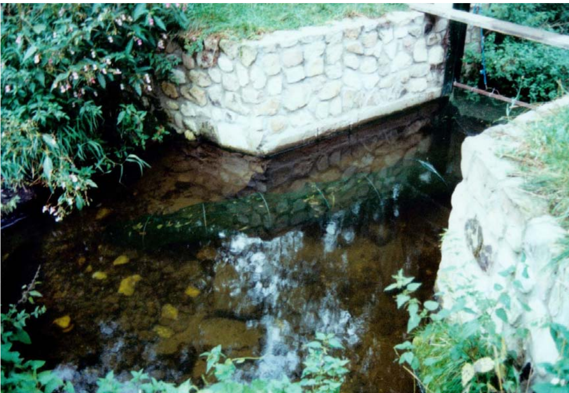
Foto 41: Fangfertige Reuse in der Fischaufstiegsanlage
