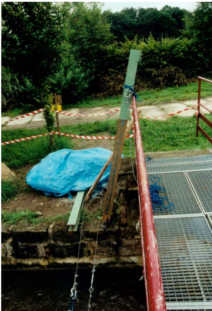
Foto 12: an Schweißnaht abgebrochener Stahlträger
