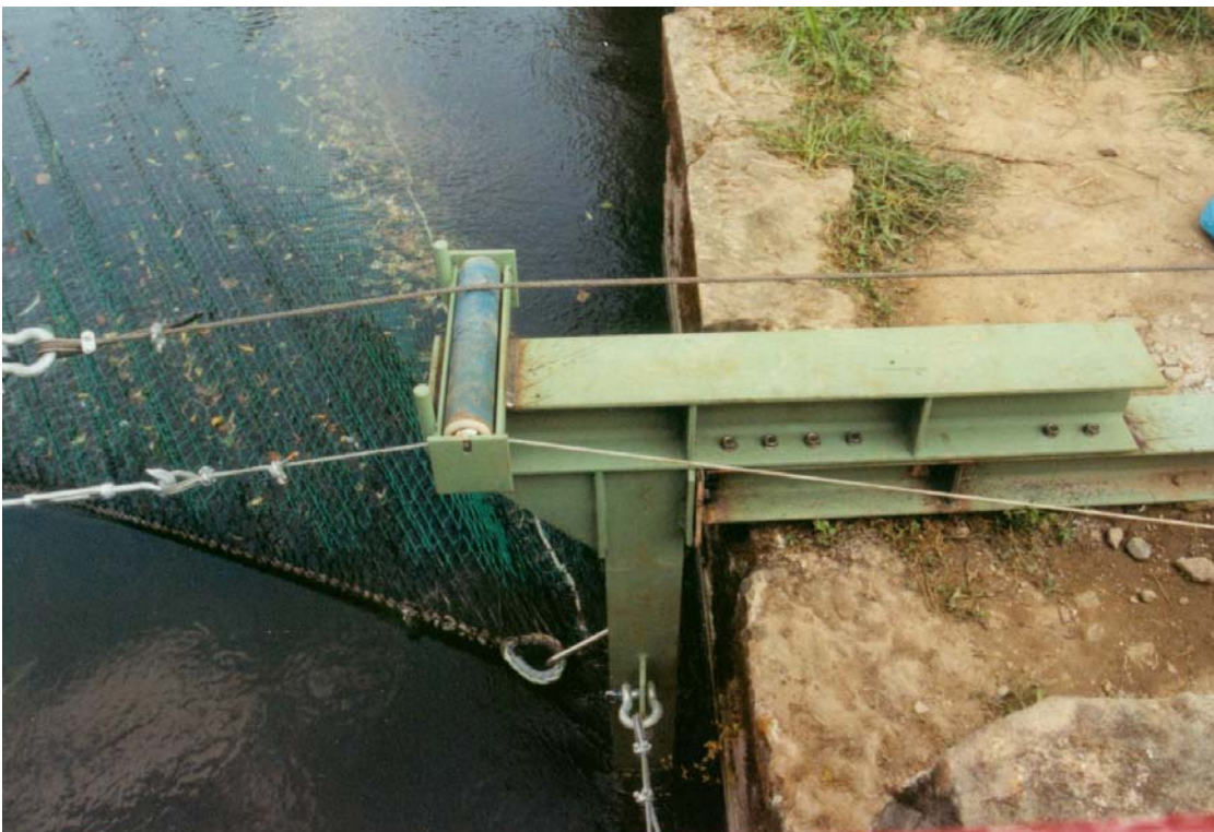
Foto 14: verstärkte rechte Hamenhalterung
