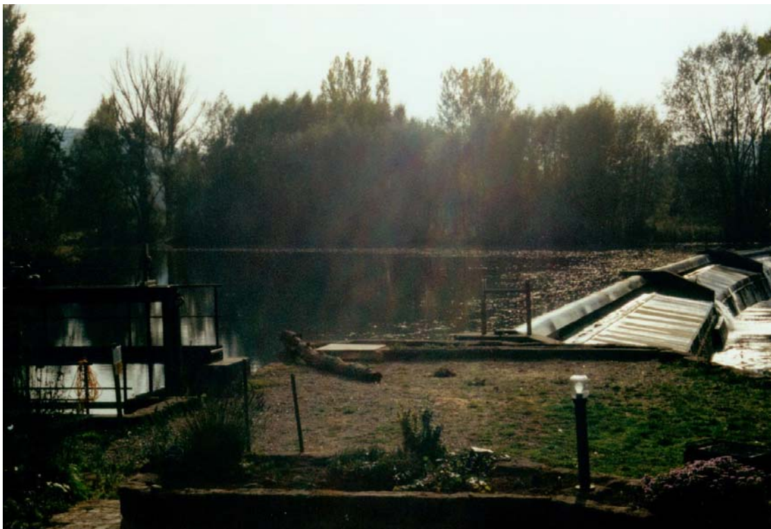
Foto 28: auf der Wasseroberfläche in Richtung Einlaufbauwerk des Mühlgrabens (links im Bild) treibendes Laub
