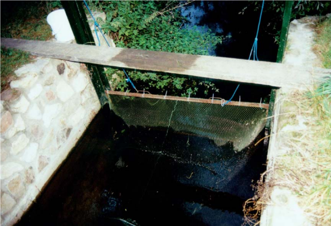
Foto 40: Reuse im Einlauf der Fischaufstiegsanlage
